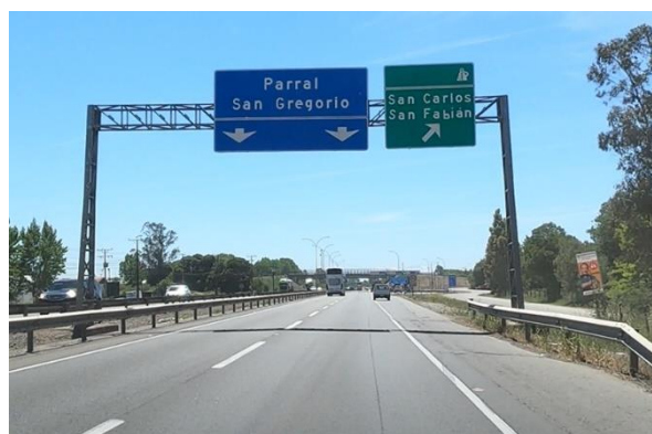
Señalización Vertical P.I. Atravesio Baena (Km 378.080)
