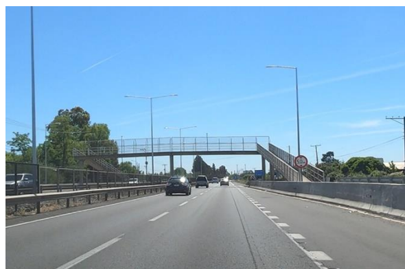
Pasarela El Oratorio (Km.392,990)
