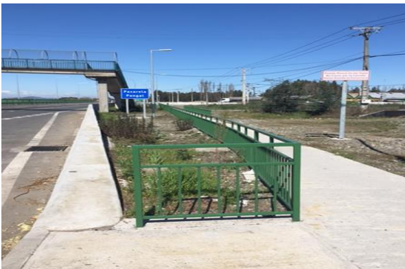
Vallas Peatonales Pasarela Pangal (Km.275,769)
