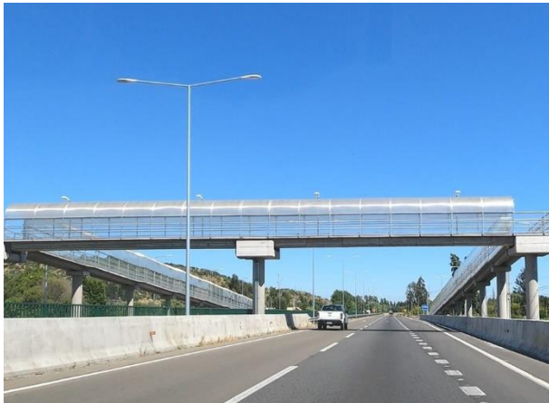
Pasarela Putagán (Km 291.810)
