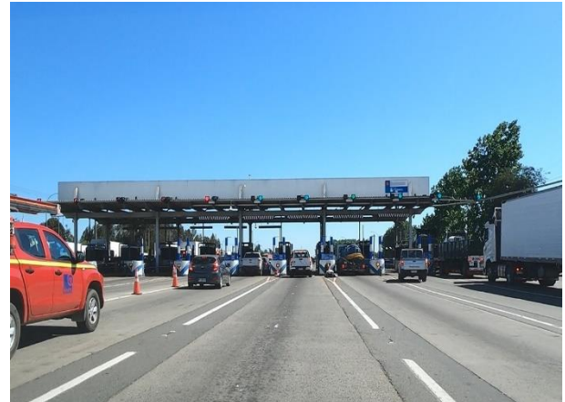
Plaza de Peaje Troncal Retiro (Km.322,560)
