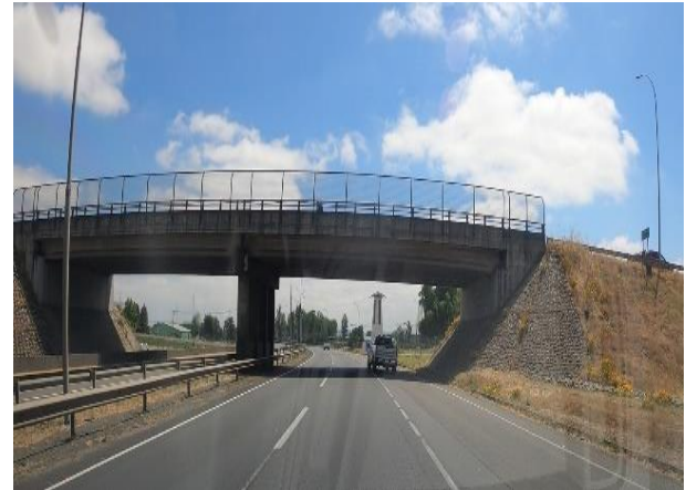
Paso P.S. San Javier (Km 273.810)
