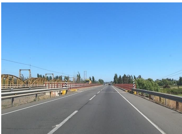
Puente Putagán Poniente (Km.294,067)
