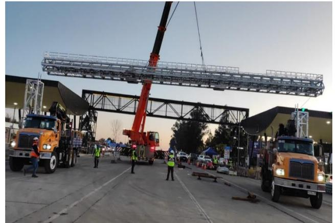
Instalación Pórtico de Cobro Electrónico MLFF en Peaje Río Claro (km 220,330)
