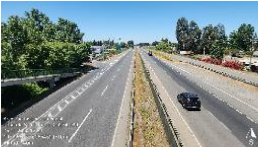
Dm 274.930 – Panorámica, Pasarela San Patricio.
