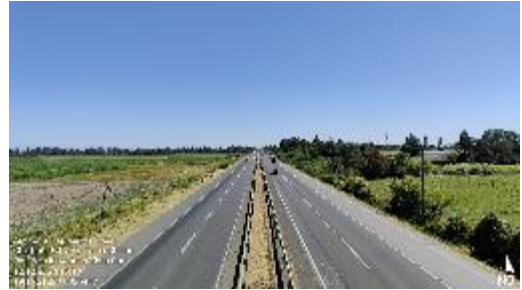
Dm 306,354 – Panorámica, Vista Norte, Pasarela La Aguada.
