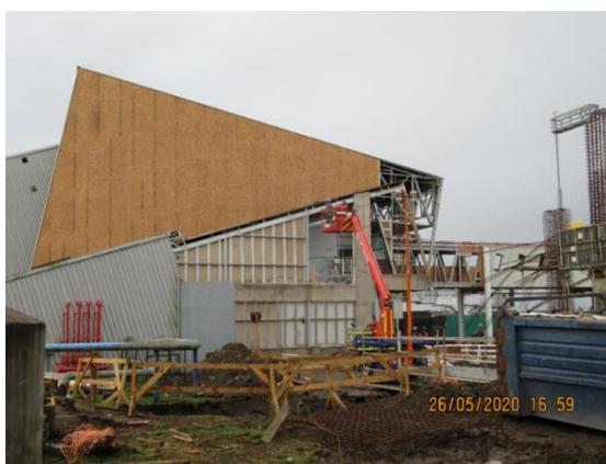
Desarme de Fachada Sur del Terminal de Pasajeros
