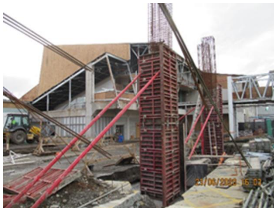
Enfierraduras y Moldaje de Pilares en Terminal de Pasajeros Sur
