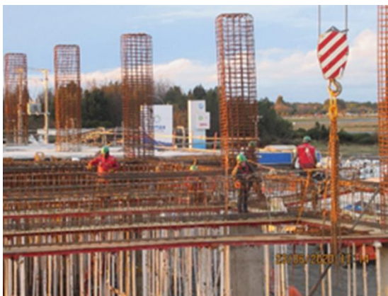
Ampliación lado norte Terminal de Pasajeros
