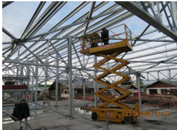
Edificio Administrativo DGAC
