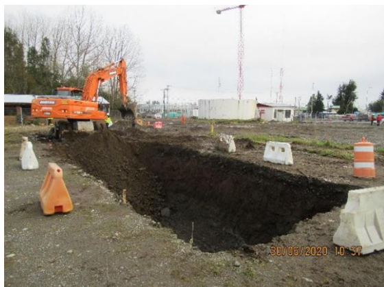
Edificio SSEI definitivo
