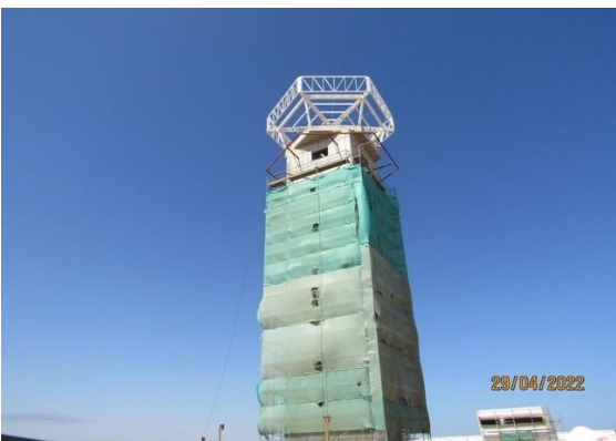
Nueva Torre de Control.
