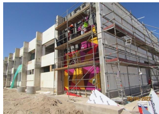
Construcción Edificio Administrativo.
