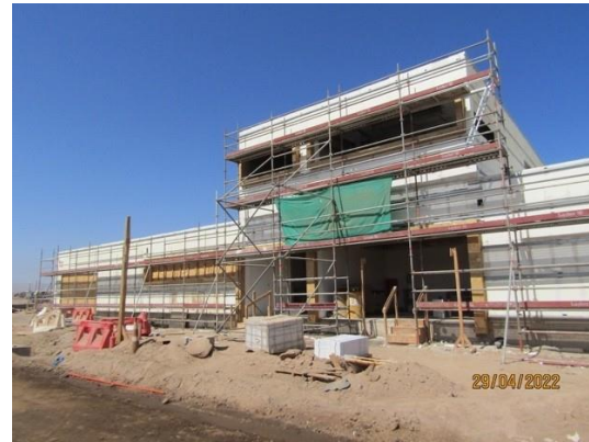
Construcción Nueva Subestación Eléctrica – DGAC.
