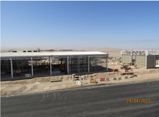
Construcción Nuevo Edificio Logístico – DGAC.
