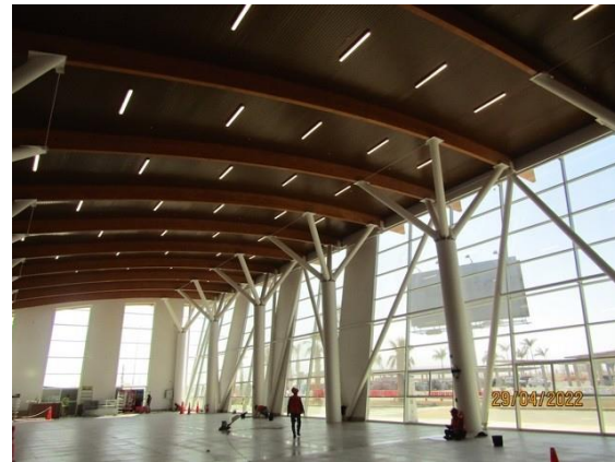
Ampliación Terminal de Pasajeros.
