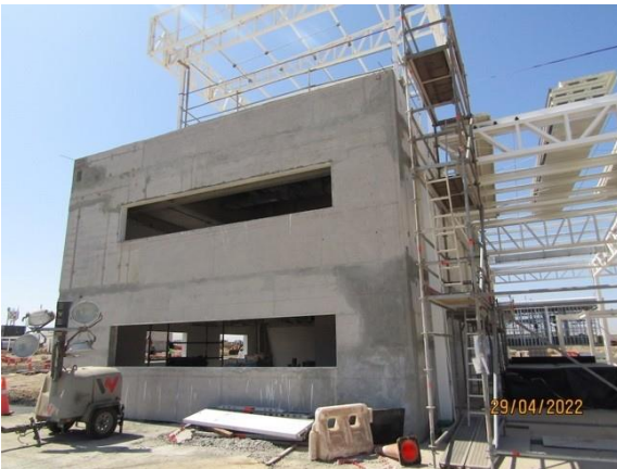
Construcción Nuevo Edificio SSEI – DGAC.
