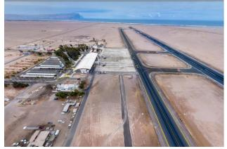
Ampliación del Edificio Terminal de Pasajeros, el cual contempla la ampliación y remodelación del actual edificio terminal, cuya superficie existente es de 5.352 m² y se proyecta según APR una superficie de 11.592 m². El edificio será ampliado en 41,5 m hacia el suroeste y 24,9 m al noreste, que por finalidad permitirá agregar 3 (tres) nuevos puentes de embarque, adicionales a los 2 (dos) ya actualmente operativos, estos últimos se reponen sumando un total de 5 nuevos puentes de embarque.
