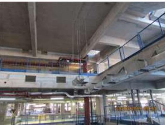
T2M Nivel 1: Instalación de Fan-coil (ductos aire acondicionado)
