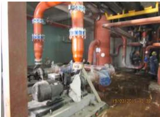
Nivel -1 -S : Sala de Bombas poniente, montaje de bombas y accesorios finalizado.
