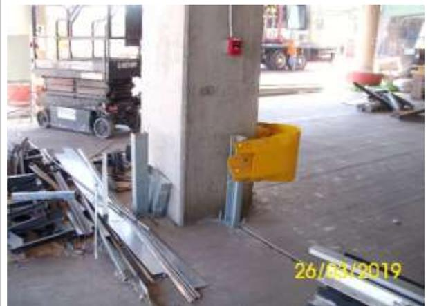
En proceso de instalación de protecciones de pilares y muros de primer piso.
