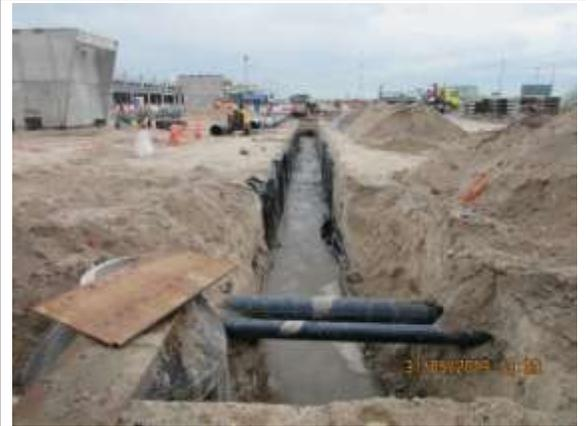
Instalación Tubería para Red Exterior Enterrada Drenajes Aguas Lluvias.
