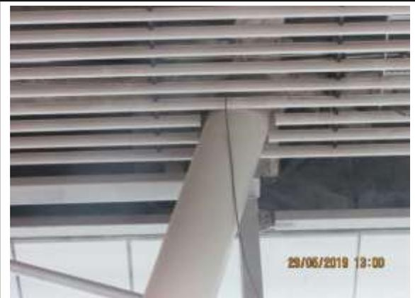
Conductor eléctrico para alimentar lámpara de ornamentación, no instalada aun en N-3
