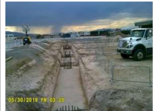
T1A: Excavación vigas de amarre eje 35
