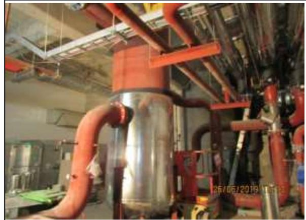
Nivel 1: Instalación de aislación a piping de salas de bombas.
