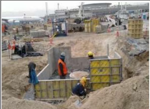
Espigón T1A: Trabajos Pilote 104, preparación prueba de carga d=1200 mm.
