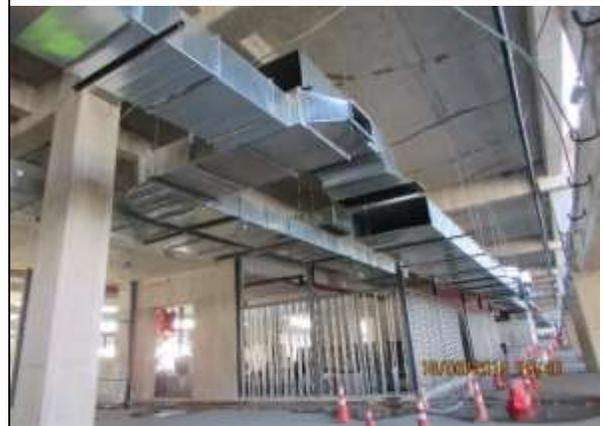
Espigón D: Nivel 1: Montaje ductos de impulsión y retorno de aire.
