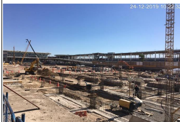
Edificio Estacionamiento Cubierto Oriente (ESO). Preparación de enfierradura de fundaciones.
