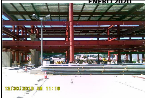
Avance de Estructura del T1A. Levantamiento estructuras Ejes 24 al 15, vista de Sur a Norte.
