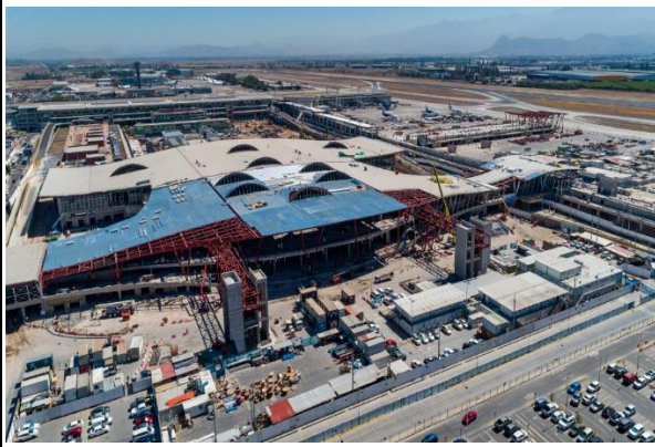
Avance de Estructura del T2M
