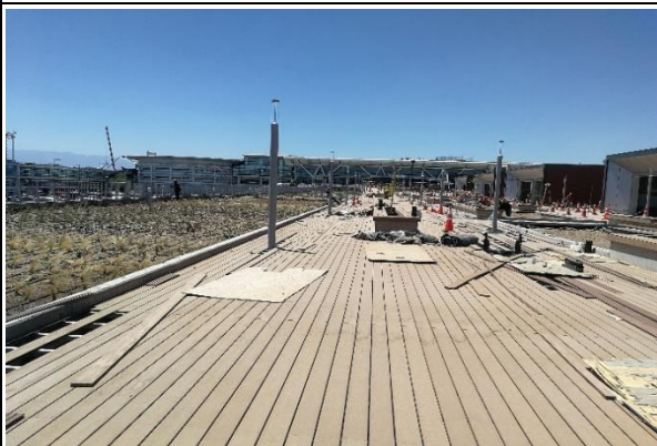
Trabajos en Cubierta, Edificio Estacionamiento Cubierto Poniente (ESP).
