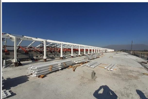
Montaje de la estructura de lucarnas en el nivel de la cubierta, en T1M
