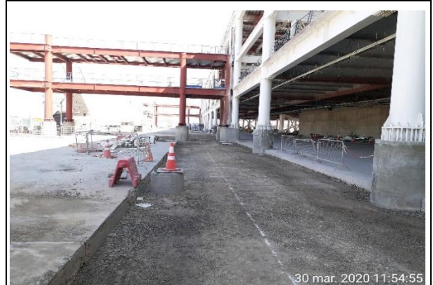
Espigón T1A: Avance obras PBB N1 y N2
