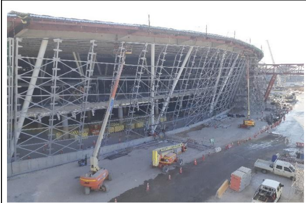
Vista fachada sur de T2M
