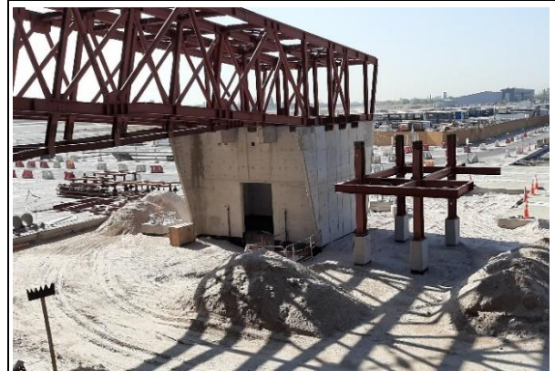
T2F: Lado sur T2F se monta parte de estructura de la escalera metálica de la PBB S3
