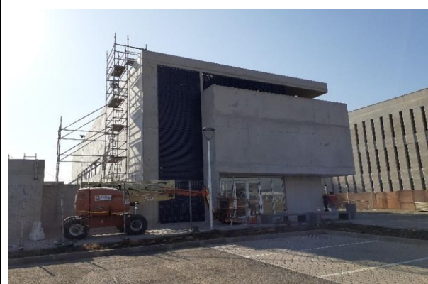
Edificio PDI: Detalle de facha poniente y colocación de celosías.
