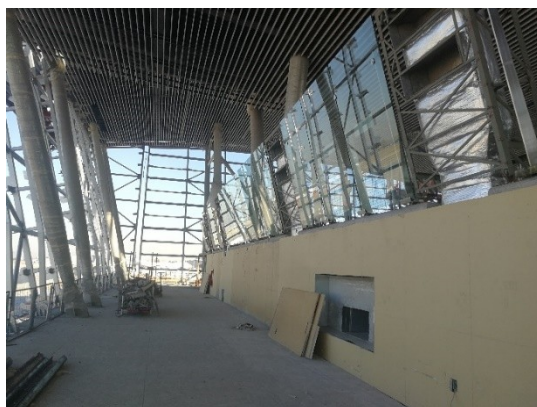
T2F: Instalación de cristales de Baranda en nivel 3
