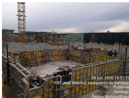
ESO: muretes nivel cubierta módulo 4.
