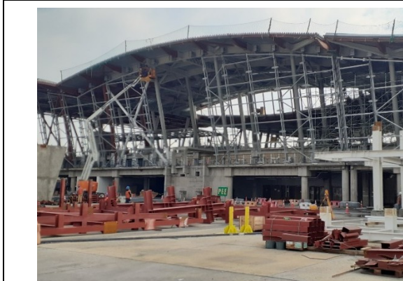
Vista general avance nivel 2, T2D
