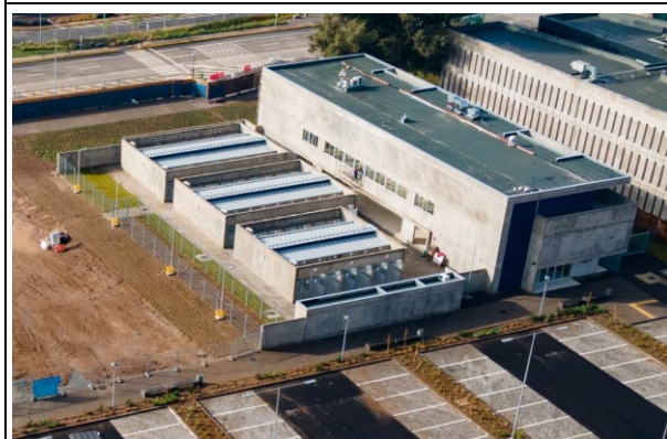
Vista general exterior edificio PDI
