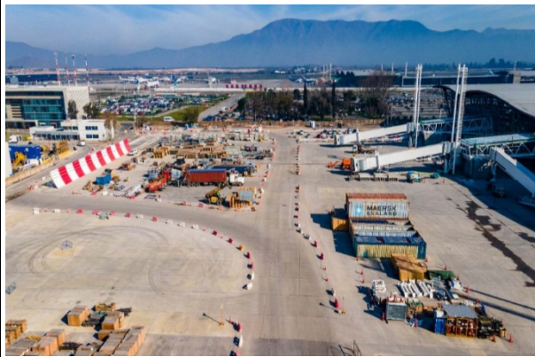
Vista general Área de Movimiento de Aviones.
