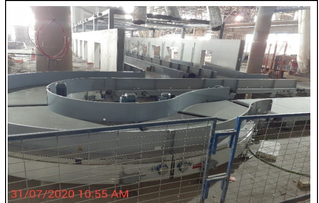
T2M, Montaje de transportadoras zona 2 del checkin.
