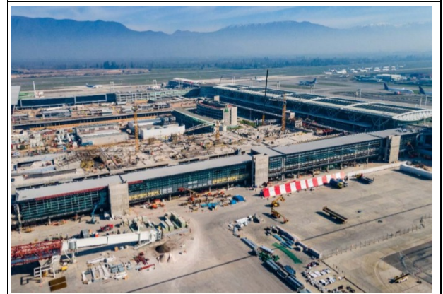
T2F: Instalación de cristales de Baranda en nivel 3
