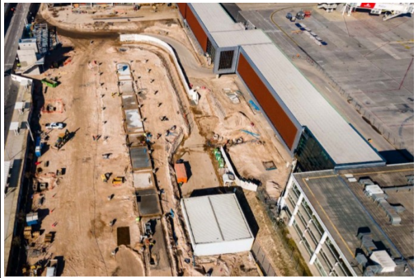
Vista general Centro de Transporte Terrestre (CTR)
