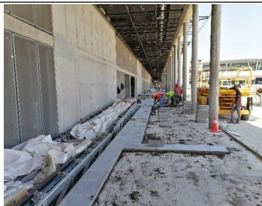
ESO: Instalación de motantes para cielo falso en nivel 2 cuerpo A
