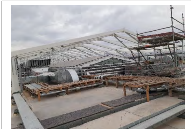
T1A: Vista general de lucarnas y estructura de cortasol.
