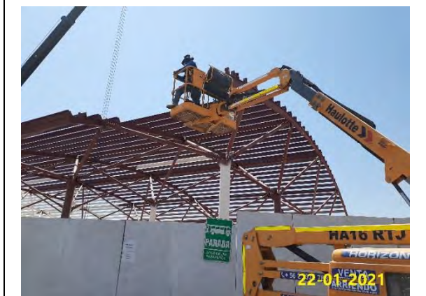
ZPB: Montaje de costaneras
