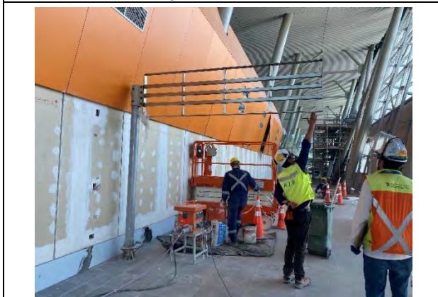
Espigón D: Instalación de soportes para señalética 22.01.2020
