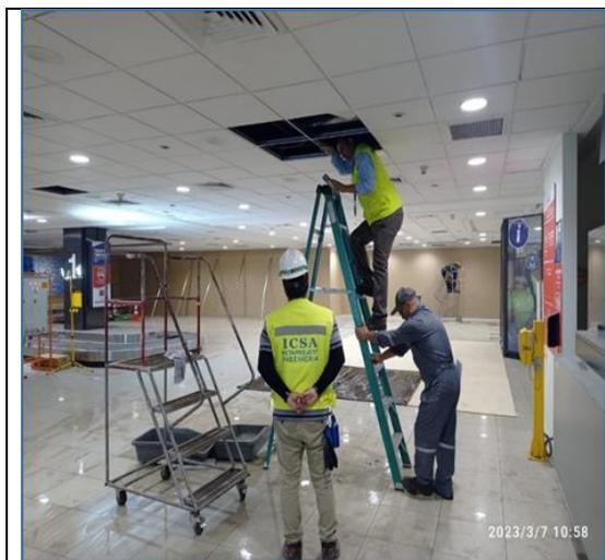
07/03/2023, Nivel 1 Lado Oriente. Inspección visual de área por filtración de agua proveniente del segundo nivel.
