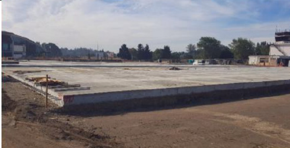
Hormigónado Plataforma Nueva PAPA
