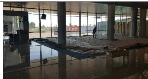
Nuevo Piso de Porcelanato
