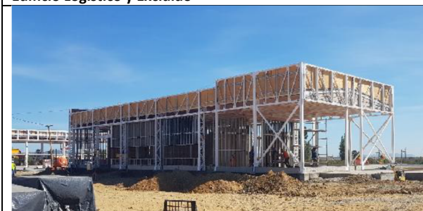
Edificio Centro de Control
