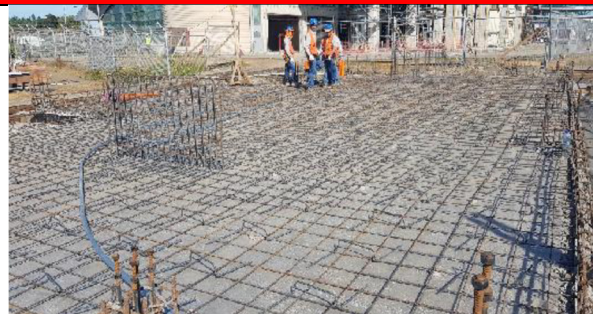
Nuevo Edificio de Rx para Carga
