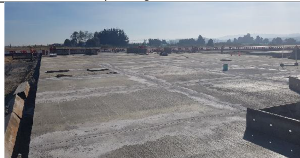
Hormigónado Plataforma Nueva PAPA
