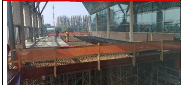
Ampliación de losas segundo piso exterior
