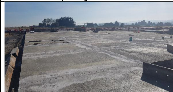
Hormigónado Plataforma Nueva PAPA
