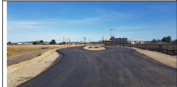
Eje 1 – Nuevo Acceso a Instalaciones DGAC
