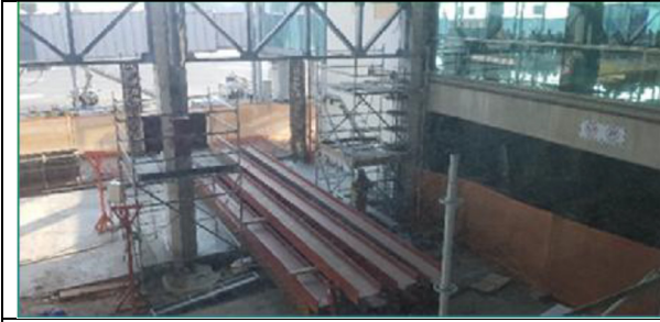
Ampliación de losas segundo piso interior
