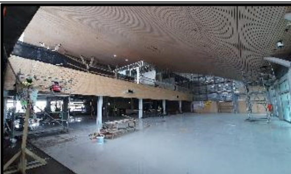
Zona 1B- 1er piso
