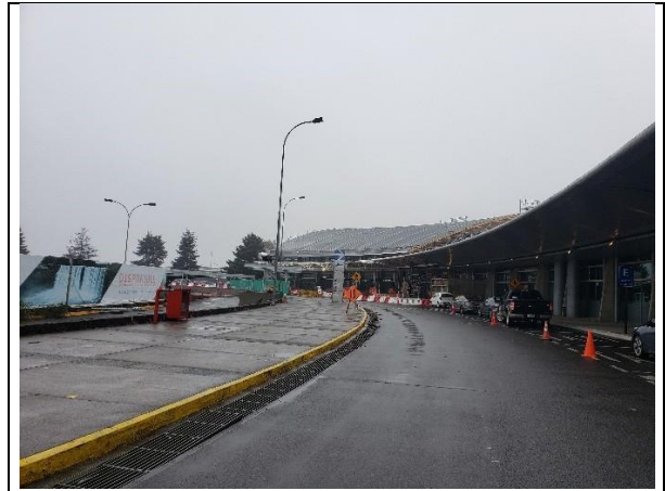
Cubierta de ampliación del aeropuerto
