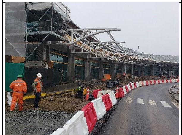
Alero de ampliación del aeropuerto
