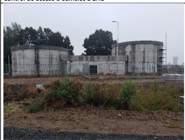
Estanques de reserva de agua potable y de incendio
