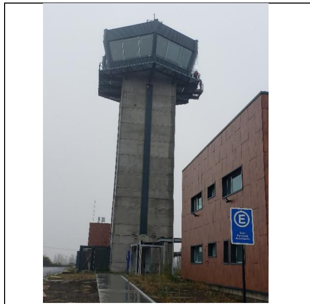
Torre de Control
