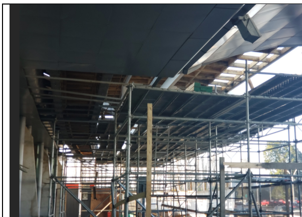
Colocación Alero Aeropuerto
