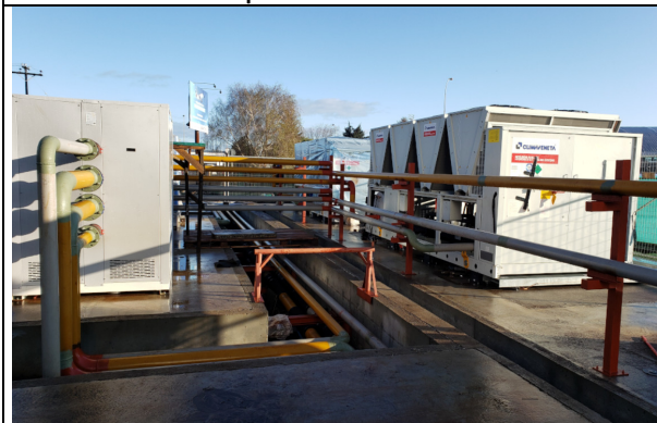
Central Térmica PAX
