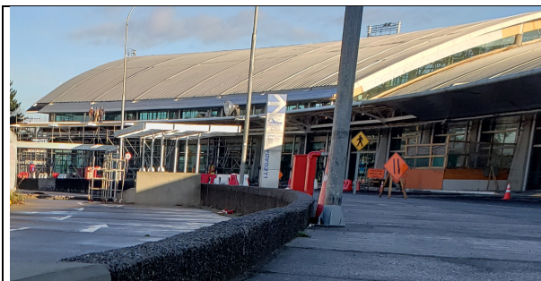
Techumbre ampliación PAX
