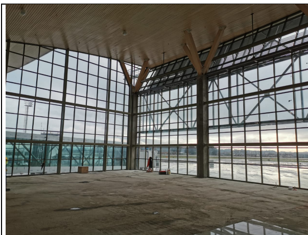
Paneles vidriados sala embarque internacional
