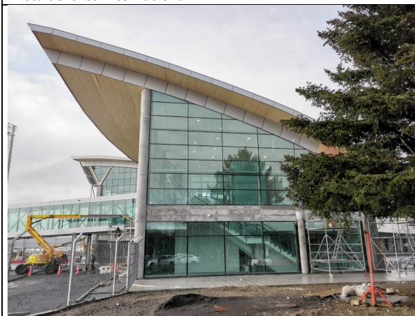
Vista exterior de los nuevos puentes de embarque
