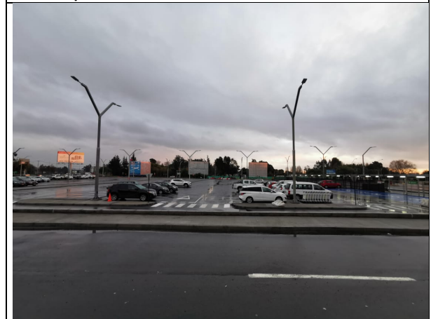
Estacionamientos – iluminación led
