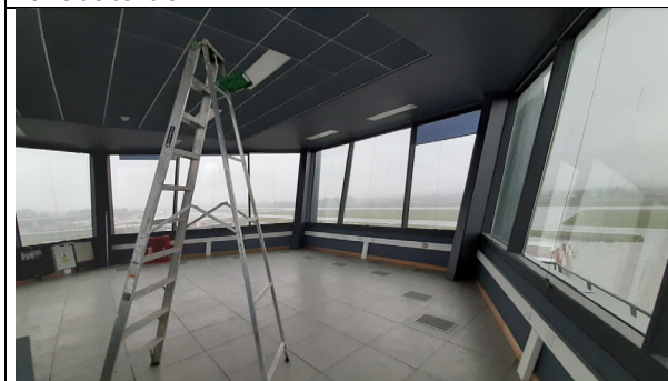
Cabina Torre de Control
