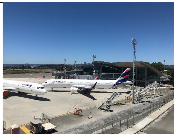
Vista del nuevo puente y área internacional
