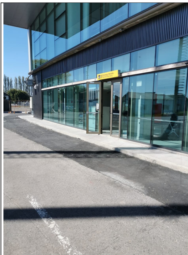
Acceso a sala de embarque remota
