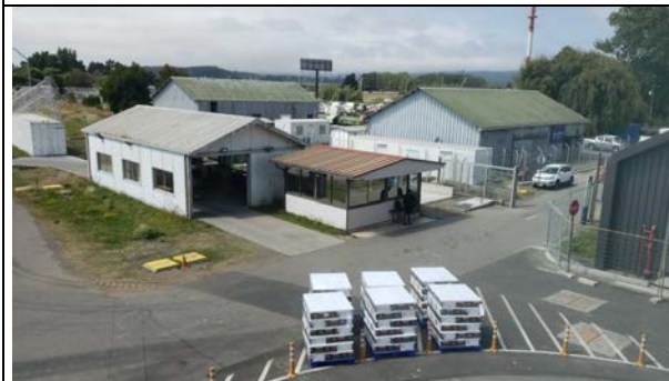
Control de acceso a zona de carga
