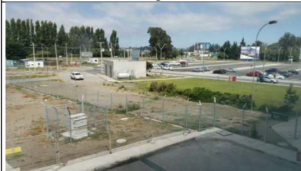
Vista de estacionamientos y acceso al aeropuerto
