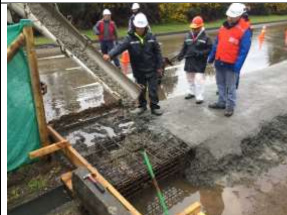
Hormigonado de canaleta en acceso estacionamientos
