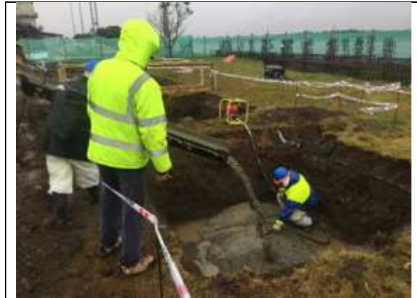
Relleno G5 en fundaciones ARO
