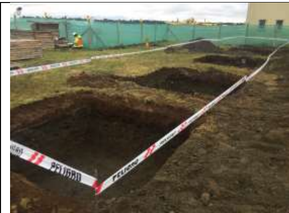
Excavación de fundaciones edificio ARO
