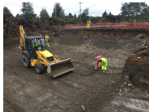
Excavaciones Planta de Tratamiento de AS
