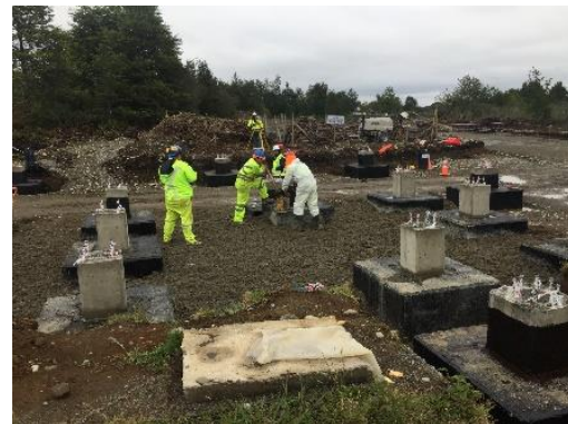
Fundaciones acceso DGAC
