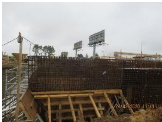
Planta de Tratamiento de Aguas Servidas
