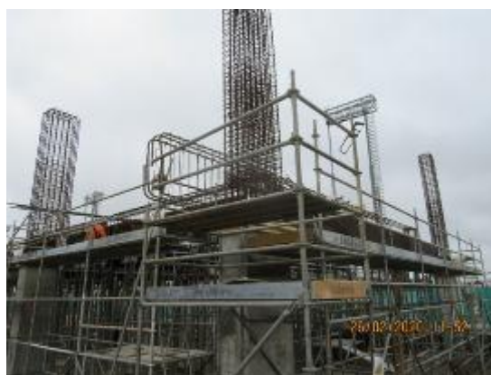
Ampliación lado sur terminal de pasajeros
