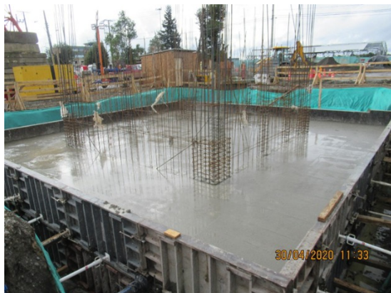
Torre de Control
