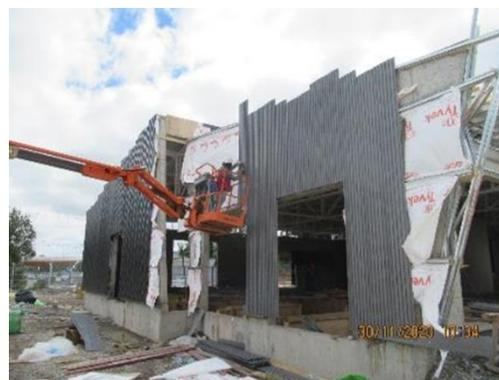
Instalación de Quadroline en fachada poniente en Subestación Eléctrica
