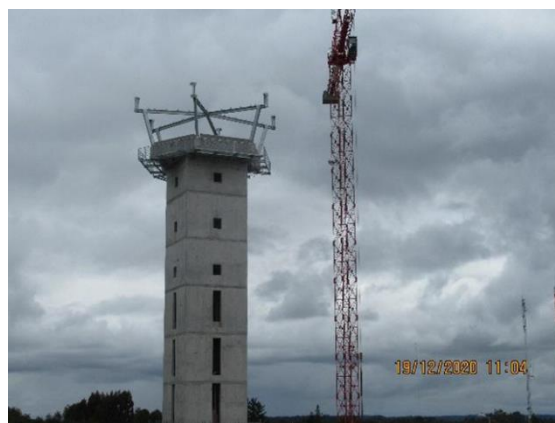
Torre de Control: Montaje estructura metálica de la Cabina
