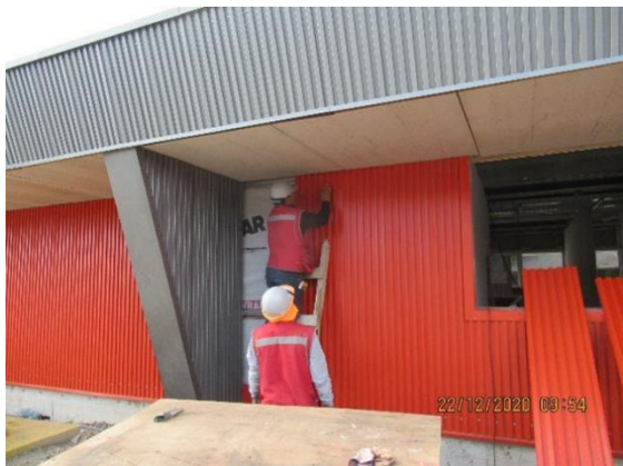
Ed. Administrativo: Instalación revestimiento Quadroline en fachadas
