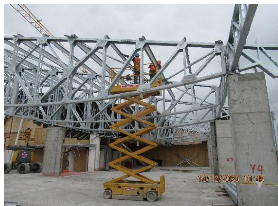
PAX Sur: Montaje de Cerchas Metálicas en estructura de cubierta
