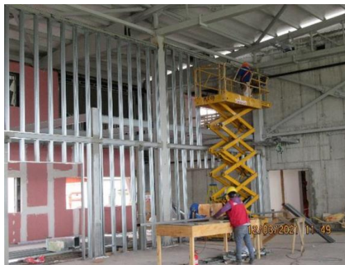
SSEE Definitivo: ESTRUCTURACIÓN TABIQUES DOBLE ALTURA
