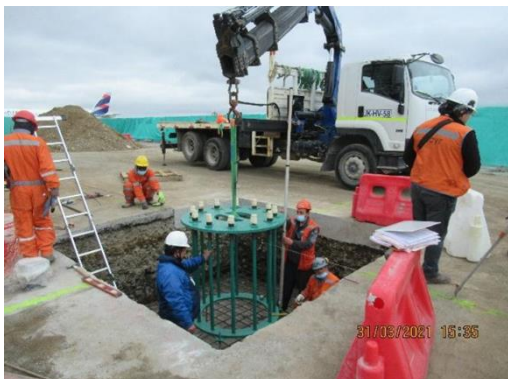
Ampliación PAX SUR: COLOCACIÓN PERNOS PARA PIVOTE EN PTE. EMBARQUE N°7
