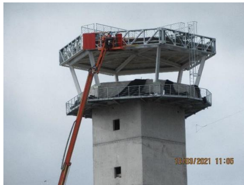
Torre de Control: INSTALACION REVESTIMIENTO QUADROLINE EN CABINA
