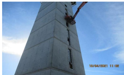
Torre de Control: INSTALACIÓN MARCOS VENTANAS EN FUSTE
