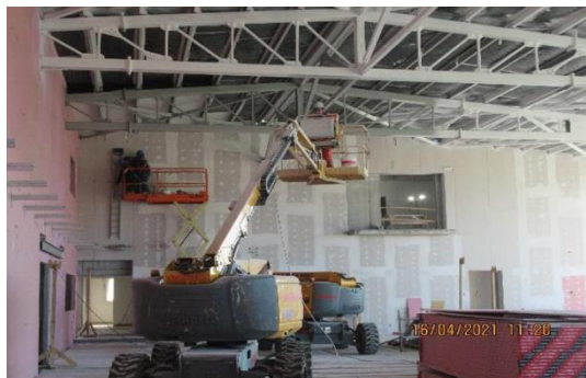
SSEI Definitivo: TOUCH UP PINTURA INTUMESCENTE EN ESTRUCTURA GALPON
