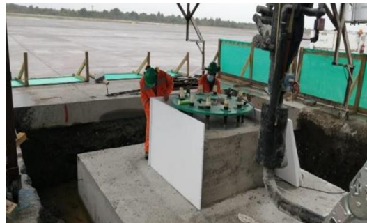
Ampliación PAX ORIENTE: PREPARACIÓN FUNDACIÓN PTE. EMBARQUE P/RELLENOS COMPACTADOS
