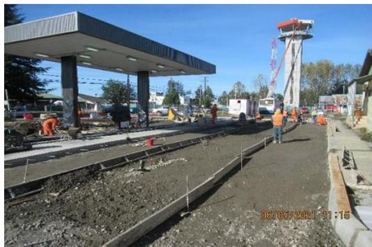
**Estación de Combustible: MOLDAJES PAVIMENTO DE HORMIGÓN**
