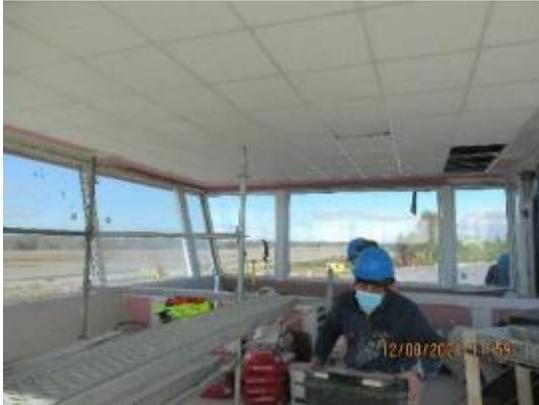
**Cuartel SSEI Def.: INSTALACIÓN CIELOS EN CABINA DE OBSERVACIÓN**
