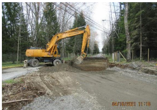
EXCAVACIÓN SELLO DE FUNDACIÓN VIALIDAD ACCESO FACH
