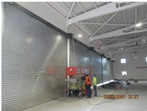
CUARTEL SSEI DEF.: INSTALAC. MOTORES DE CORTINAS METALICAS ENRRROLLABLES
