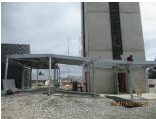
PASARELAS DGAC: INSTALACIÓN CUBIERTA EN CONEXIÓN ADM-TWR
