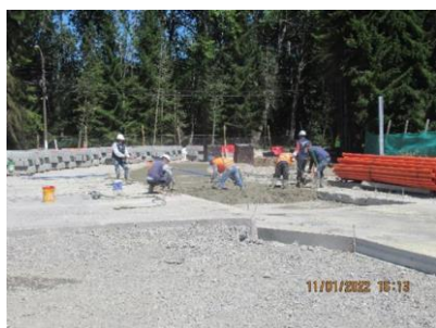
HORMIGONADO CALZADA EN VIALIDAD ACCESO FACH
