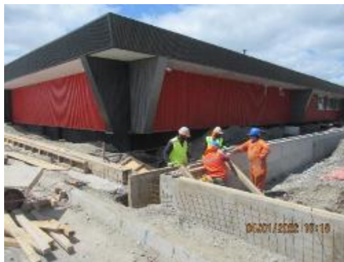
HORMIGÓN CANALETA N°4 (EDIF. ADMINISTRATIVO)
