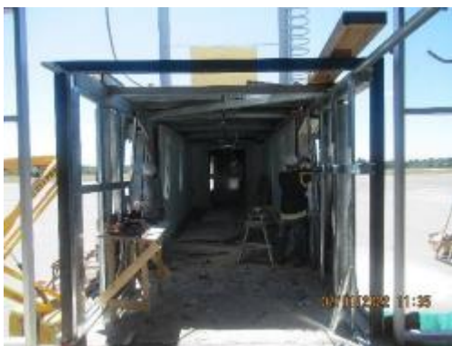
Ampliación PAX SUR: DESARME PUENTE DE EMBARQUE N°5
