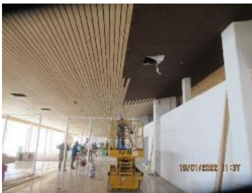
Ampliación PAX SUR: INSTALACIÓN CIELO DE MADERA DECOFAZ
