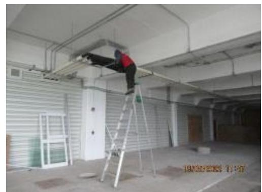
Ampliación PAX SUR: AISLACIÓN TÉRMICA TUBERÍAS DE CLIMATIZACIÓN
