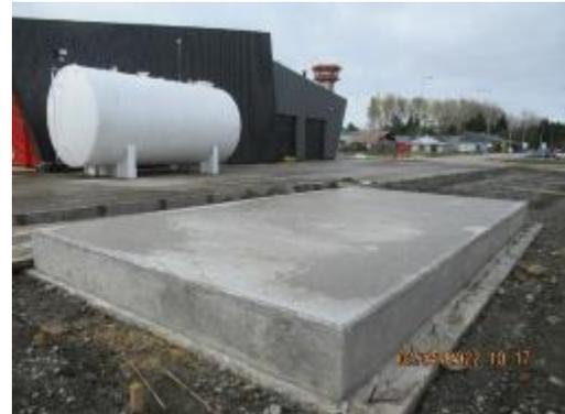
S/E ELÉCTRICA: HORMIGONADO LOSA DE FUNDACIÓN ESTANQUE PETRÓLEO
