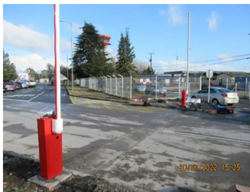
INSTAL. BARRERAS AUTOMÁTICAS EN ACCESO A ESTACIONAMIENTOS AVSEC CARGA
