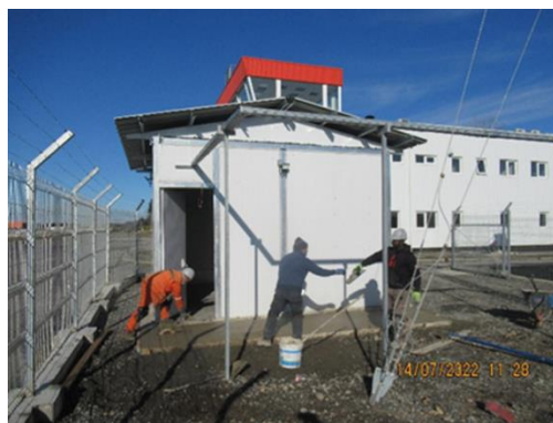
CASETA RX: CONFECCIÓN DE RADIER DE HORMIGÓN EN ACCESO
