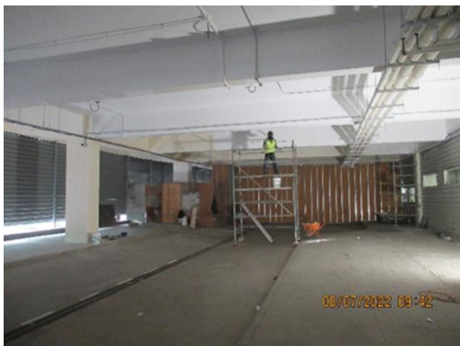
PINTURA DE VIGAS Y FONDO DE LOSA EN CAMINO AERONÁUTICO (NORTE)
