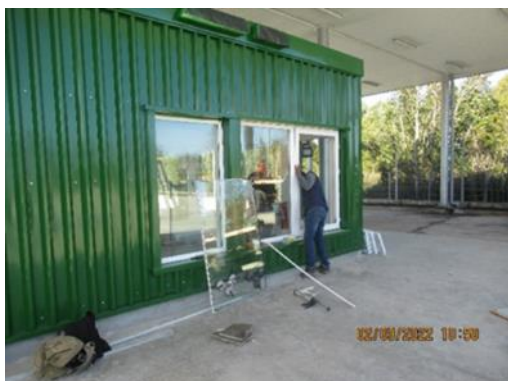
Acceso FACH: INSTALACIÓN TERMOPANELES EN VENTANAS
