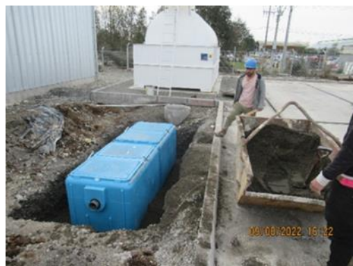
S/E Eléctrica: INSTALACIÓN CÁMARA SEPARADORA HIDROCARBUROS
