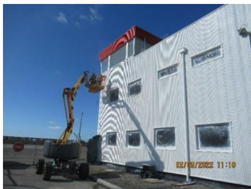
Cuartel SSEI: REPASO DE PINTURA EN REVESTIMIENTOS DE FACHADA
