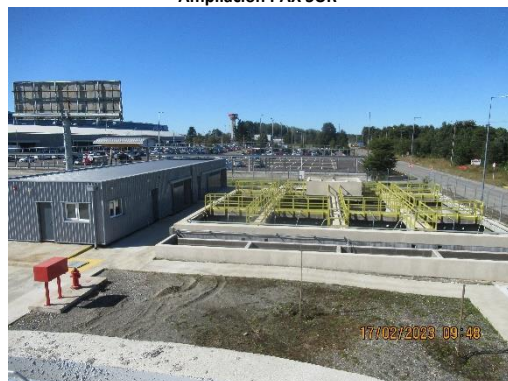
Planta de Tratamiento de Aguas Servidas (PTAS)
