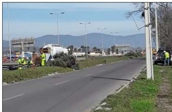
Ruta 5, Dm 469+900 Trabajos de mantención infraestructura urbana
