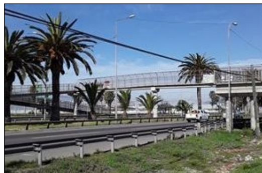
Ruta 5, Dm 471+700 Pasarela Huanhualí
