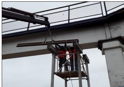
Ruta 5, Dm 460+500 alzaprima reparación Provisoria Pasarela Los Copihues
