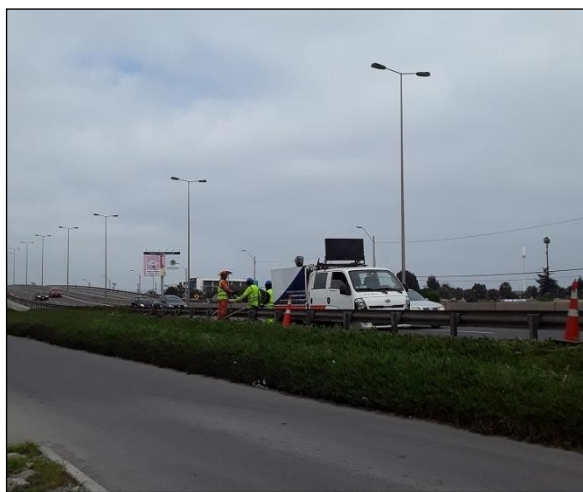
Ruta 5, Dm 470+100 Roce y limpieza Cunetas
