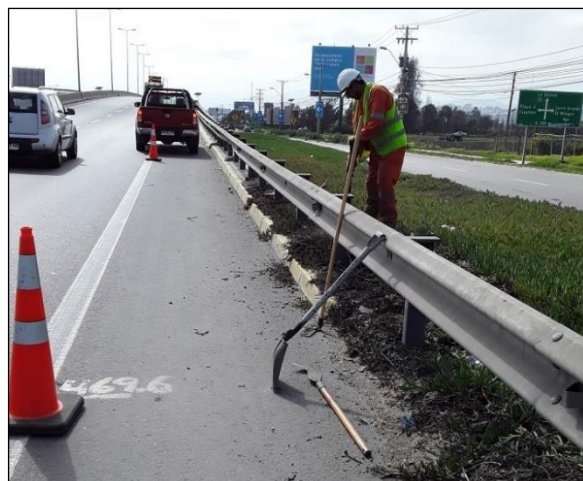
Ruta 5, Dm 469+600 Roce y Limpieza Faja derecha
