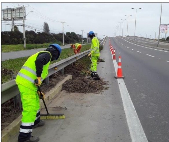
Ruta 5, Dm 470+100 Despeje y Limpieza Cunetas
