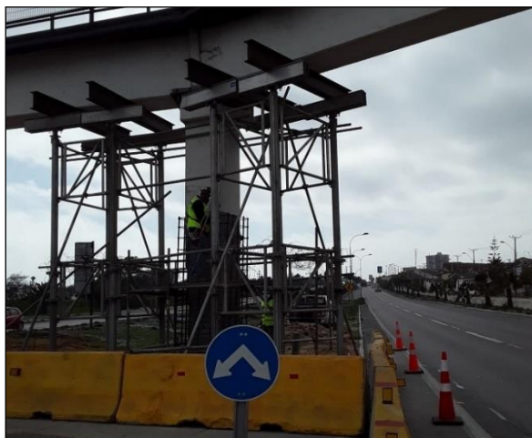
Ruta 5, Dm 460+500 Trabajos Pasarela Los Copihues
