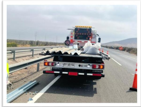
Foto 2: Ruta 5, Dm 336+700 reparación de defensas camineras y retiro de elementos dañados.
