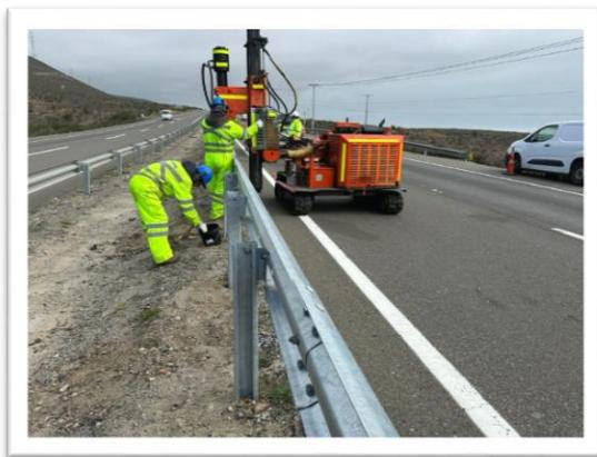
Foto 1: Ruta 5, Trabajos de instalación de barreras, tramo interurbano, proyecto seguridad vial.
